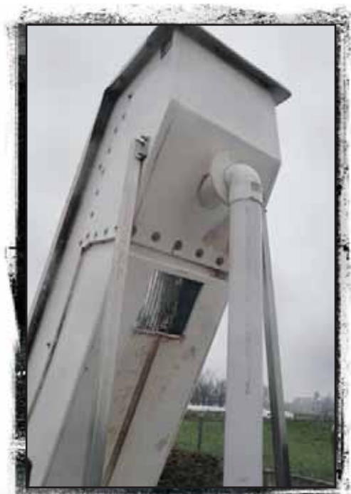
f Foto 12.11. Tamiz ubicado previo al ingreso de la laguna de estabilización en la EEA Rafaela (INTA).
