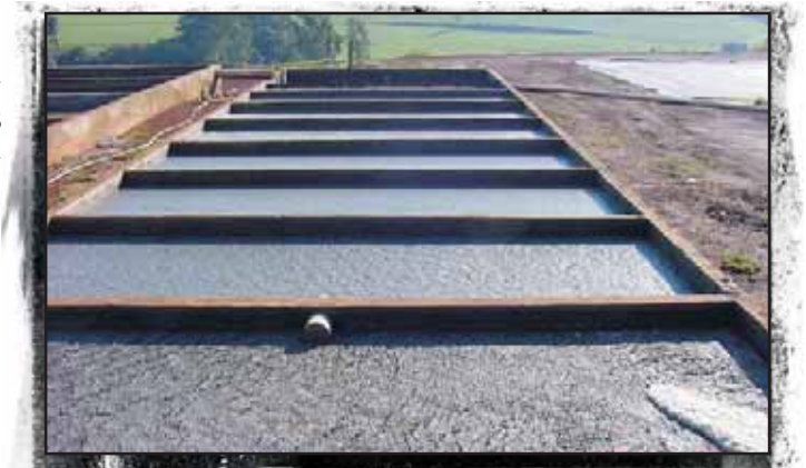
f Foto 12.9. Lagunas impermeabilizadas.
