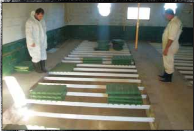
f Foto 12.3. Piso enrejado, gentileza Est. Vedia Chaco (INTA).
