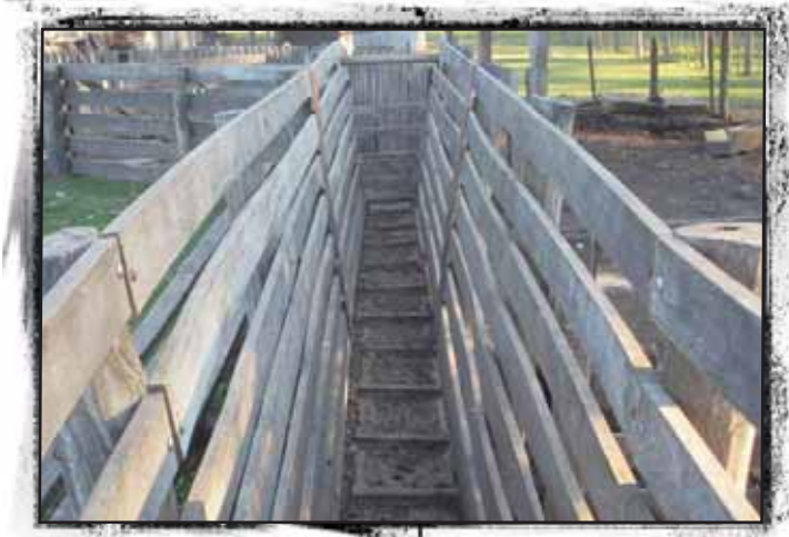
f Foto 5.3. Manga con detalle de tacos en el piso para evitar el deslizamiento de los animales.
